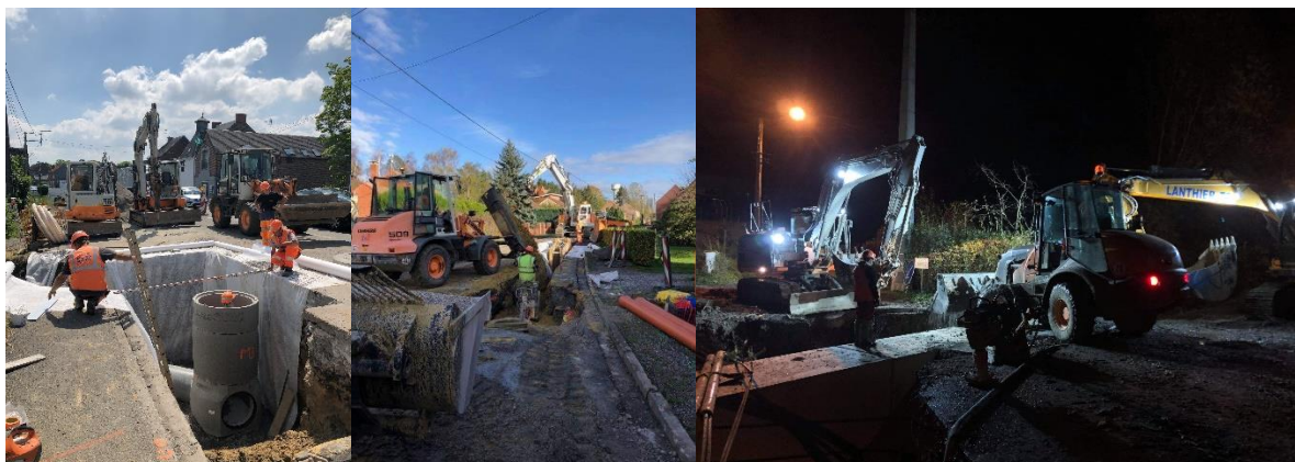
Trois chantiers de la STPA
